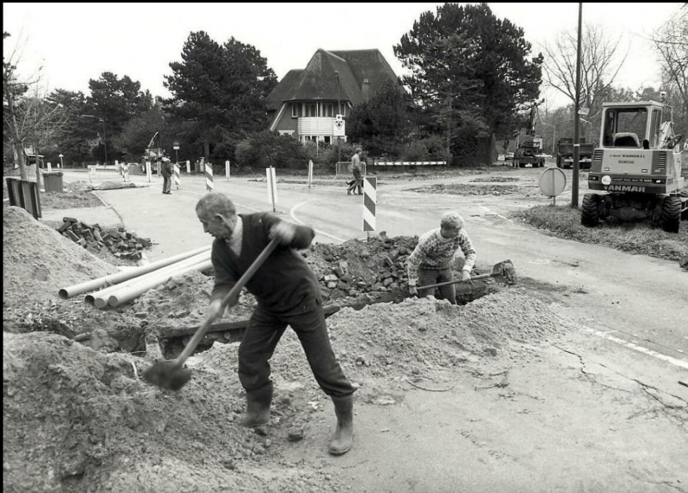
De werkzaamheden in 1987 aan het begin van de Zeeweg bij de Militairenweg. Het aantal rijstroken op ieder rijbanen wordt terugbracht van twee naar één. Aan de overkant is te zien dat men vanaf de Zeeweg nog de Spoorlaan kan oprijden. Deze afslag is toen ook afgesloten
